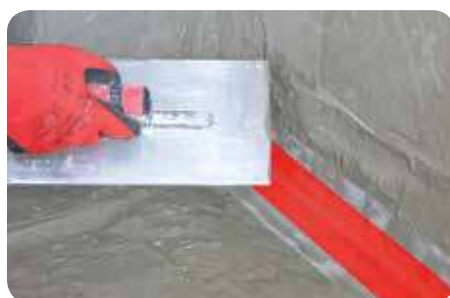
Das Einlegen von Plastikbändern an den Ecken.
