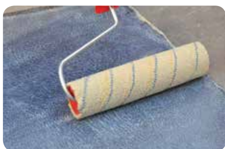
Behandlung mit HYDRO PRIMER
