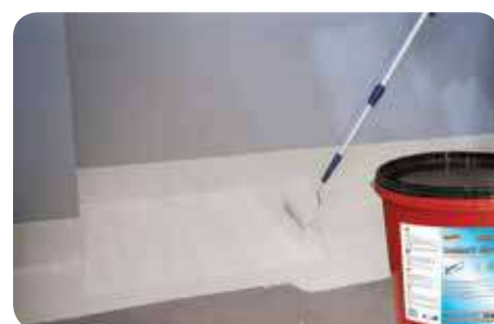
ANWENDUNG von Izoelastic Liquid
